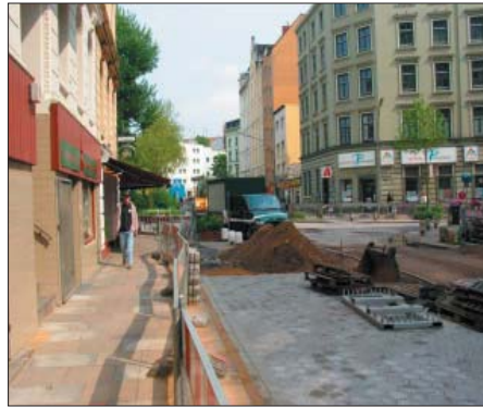
Bauarbeiten in der Brigittenstraße
